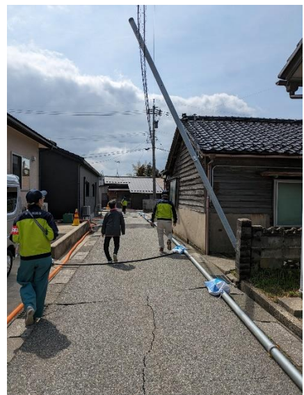
能登半島地震による被害の様子② (2024年4月5日・齊藤まり子都議撮影)
