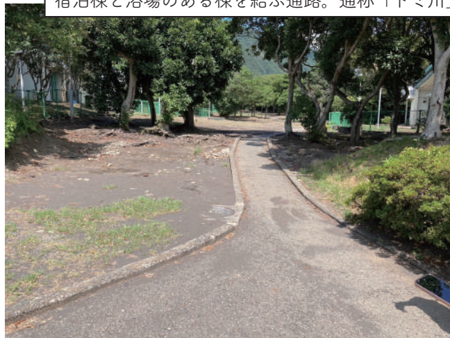
雨水により土が流され樹木の根が露出
