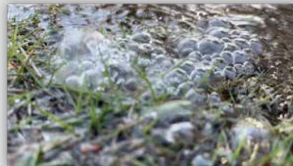
リニア工事で、気泡が発生
