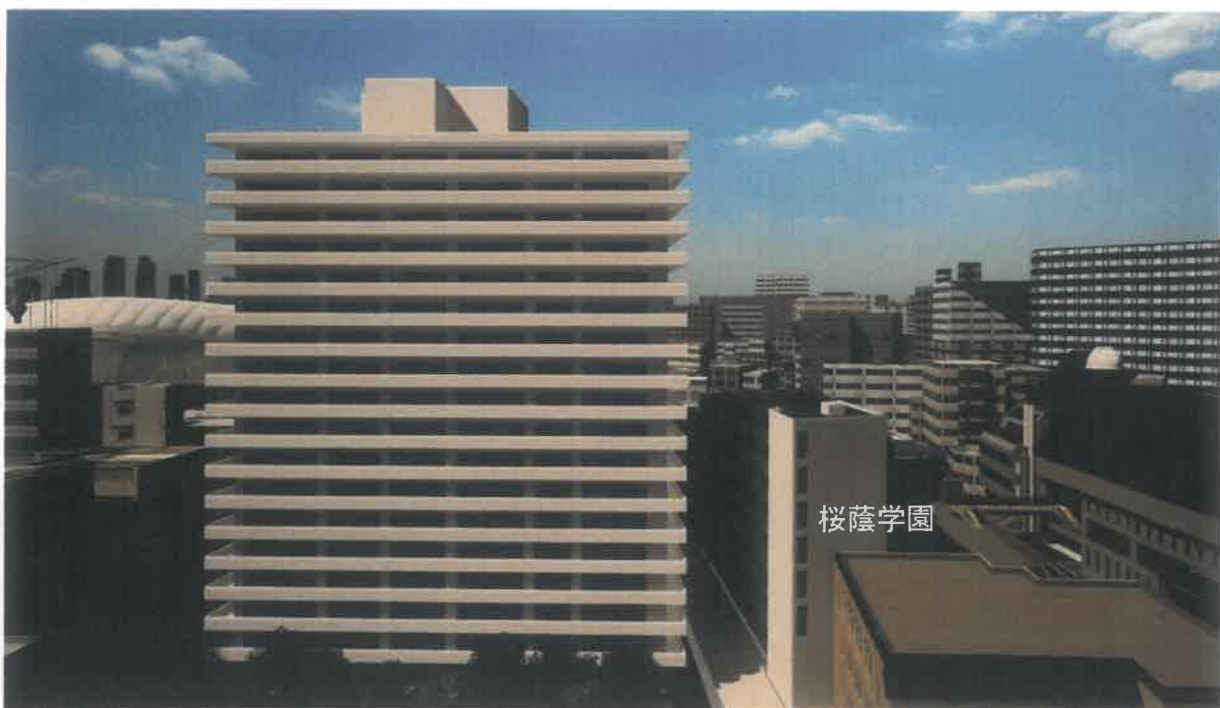
本館南側(建設後)
